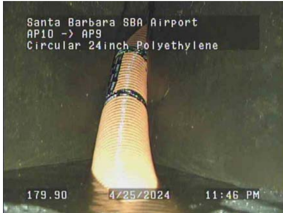
179.90ft Discharge Point / AP9
